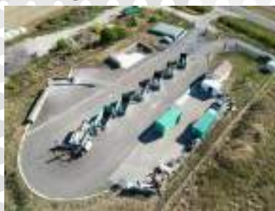
Déchèterie de Brienne-le-Château
