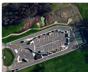
Déchèterie de Piney
